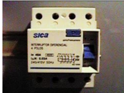
Interruptor diferencial tetrapolar SICALIMIT 4 x 40A - I_{\Delta} = 0,03A
