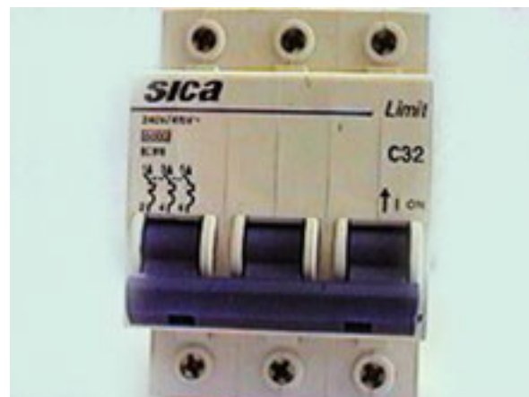
Interruptor termomagnético tripolar de 32 A
