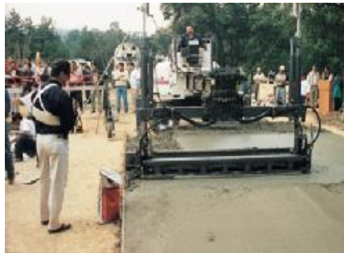
Figura 7.1-3 Colocación de concreto con regla láser.
