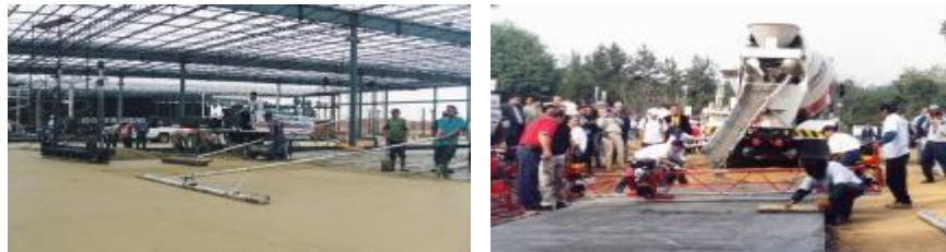
Figura 6.4-1 Regla vibratoria y regla láser empleados para colados en franjas y en bloques respectivamente, en proyectos de pisos industriales.
