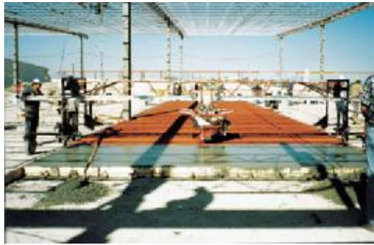
7.1-14 Dosificación de endurecedor en polvo con equipo mecánico.
