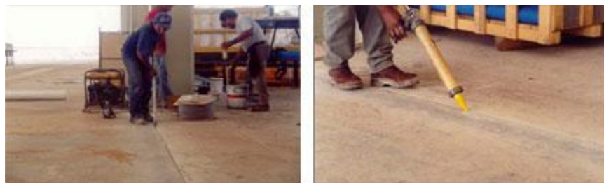
a) Colocación de cintilla de respaldo.
