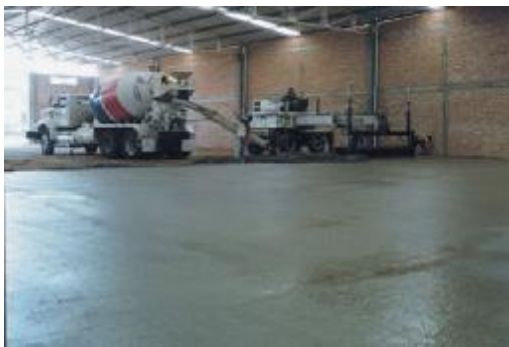
Figura 6.2-3 Descarga del concreto en camión revolvedor.
