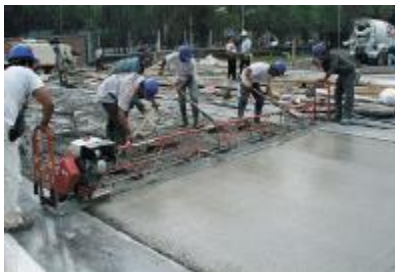
Figura 7.1-2 Enrasado y vibrado de concreto con regla vibratoria.
