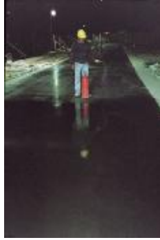
7.1-12 Operación de curado mediante aspersores de membrana.
