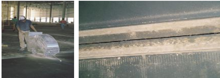
Figura 6.9-1 Corte empleando equipos de corte temprano y vista del corte temprano realizado en seco.
