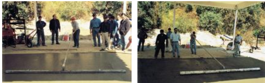
Figura 6.5-1 Nivelación de la superficie con herramientas que permiten ir corrigiendo la planicidad, como el check rod (izquierda) y el bump cutter (derecha).
