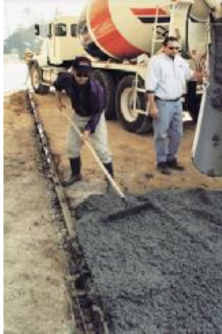
Figura 6.3-1 Extendido del concreto empleando palas cortas de bordes cuadrados.
