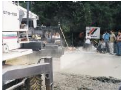
7.1-15 Dosificadora láser para endurecedores en polvo.
