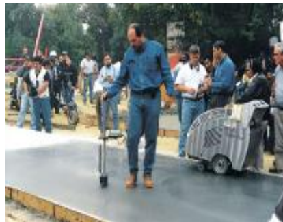
Figura 6.10-2 Medición de planicidad empleando el Dipstick, durante el proceso constructivo después del pulido de la superficie y antes del corte.
