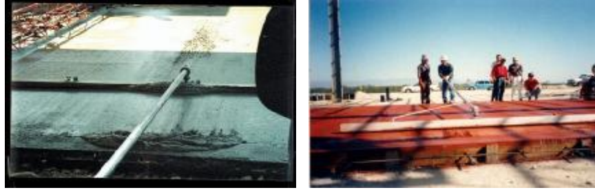
Figura 7.1-6 Corte de puntos altos y relleno de bajos (corrección de planicidad) con el empleo del Bump .
