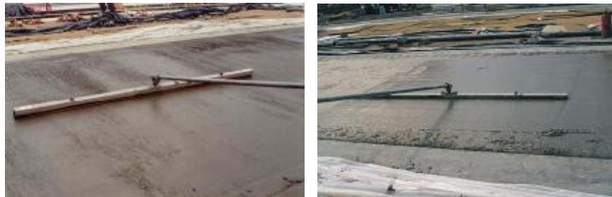
Figura 7.1-5 Flotado del concreto y corrección de planicidad con el empleo del check rod.
