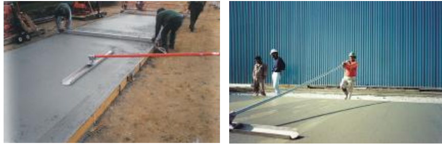
Figura 7.1-4 Flotado del concreto mediante la flota tipo canal.
