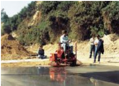
Figura 6.8-1 Pulido de piso industrial con allanadora mecánica (comúnmente llamados helicópteros).
