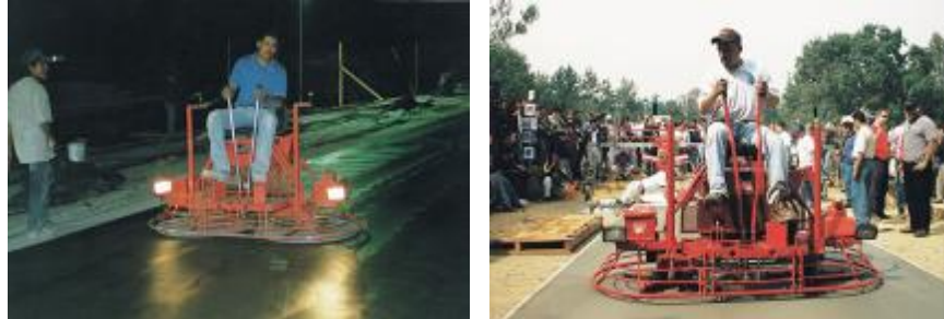
7.1-10 Allanadoras dobles con operador a bordo en operaciones de flotado y de pulido.
