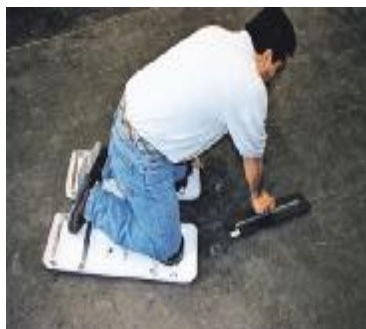
7.1-21 Zapatos tipo ski para trabajar en el acabado del concreto.
