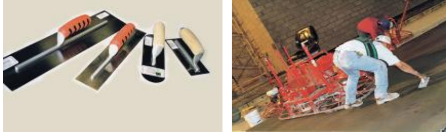
7.1-19 Vista y aplicación de flotas manuales de acero.
