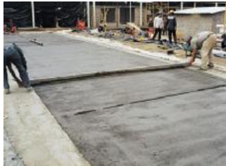
Figura 7.1-7 Aplicación de la regla tipo escantillón.
