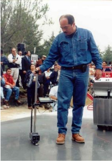
Figura 3.3-2 Medición de Planicidad con el aparato Dipstick.
