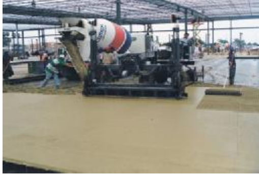
Figura 6.2-2 Colados en áreas grandes con regla láser.
