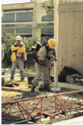
Figura 7.1-8 Vibrador de tipo mochila para el vibrado adicional al de la regla.
