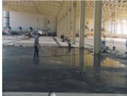
Figura 6.10-1 Curado de losa de concreto, mediante la aplicación de membrana de curado.
