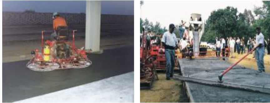
Figura 6.6-1 Flotado de concreto con allanadora con discos de flotado y herramienta de corrección de planicidad (bump cutter) a 45 grados del eje del colado entre operaciones de flotado.
