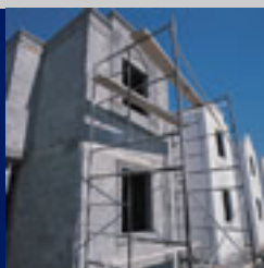
Conjunto Habitacional Reynosa, Tamps.
