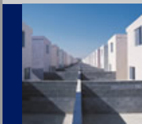
Conjunto Habitacional Reynosa, Tamps.
