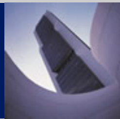
Torre Dataflux Monterrey, N.L.
