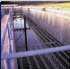
Planta Tratamiento Aguas Ensenada, B.C.
